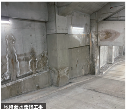
地階漏水改修工事
