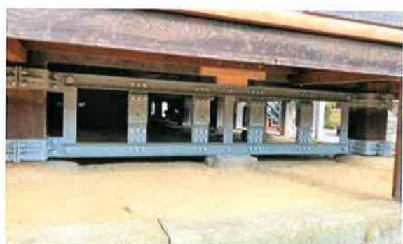
部分補強のため、従来の工法よりコストダウンが可能
