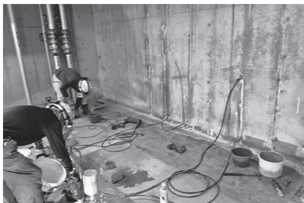
止水 地下 止水材注入
